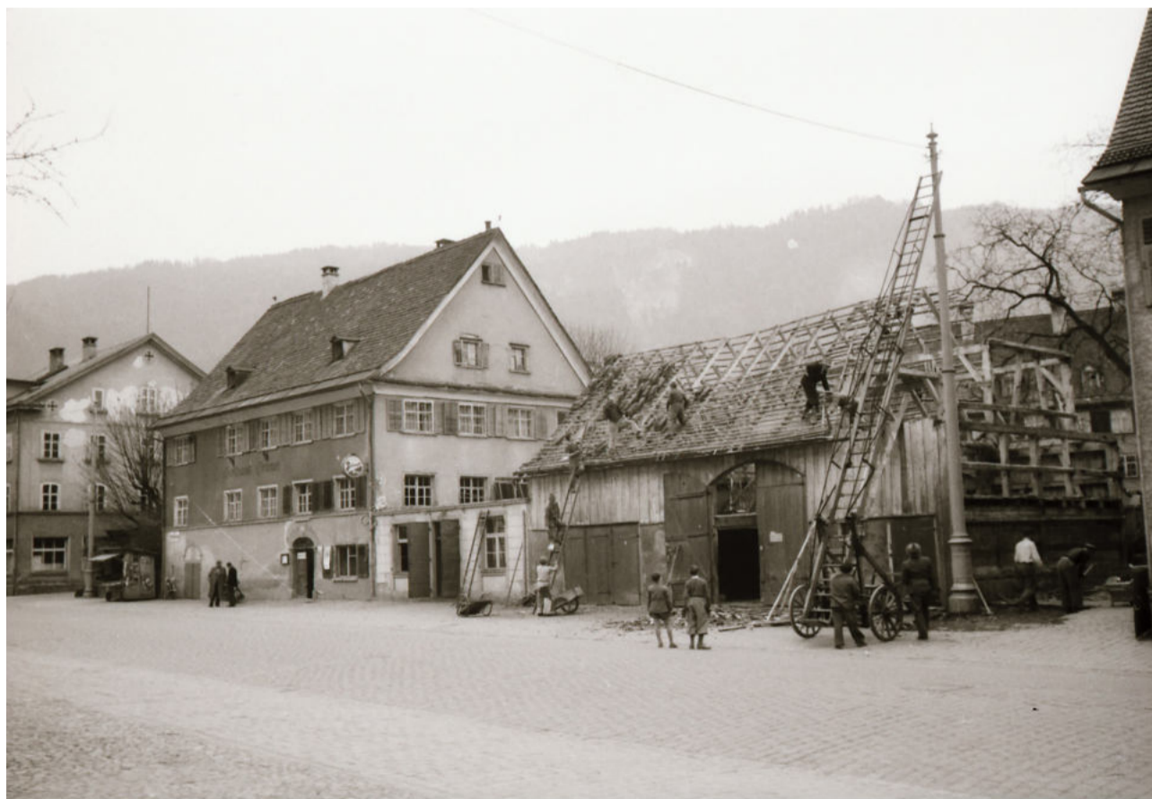
Hotel Messmer – Abbruch des Stadels, Anfang 1950er-Jahre
